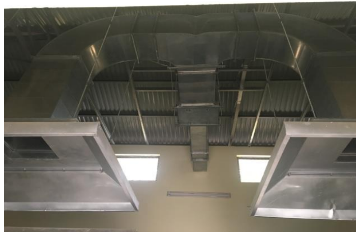
Hình 20. Phễu thu hơi và khử mùi tại khu vực lò hấp
