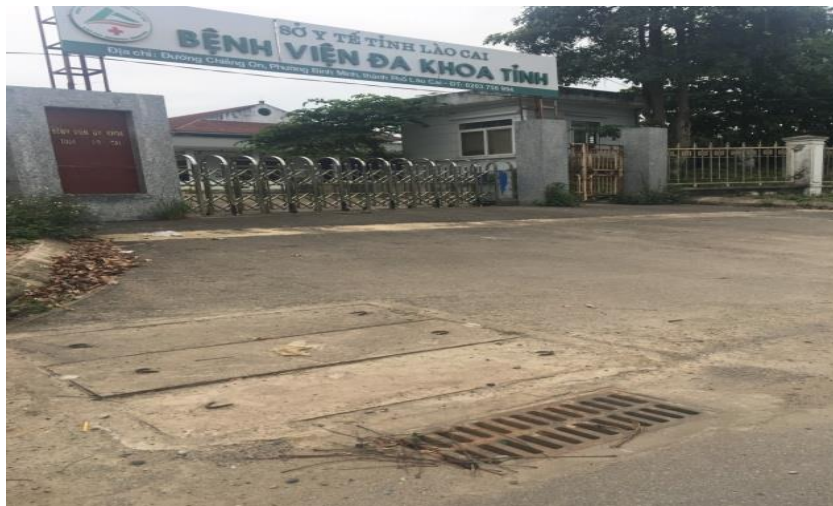
Hình 4. Hố ga thoát nước mưa trên đường Võ Nguyên Giáp
