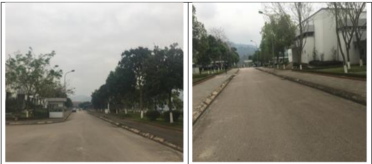
Hình 2. Đường nội bộ trong Bệnh viện hiện tại
