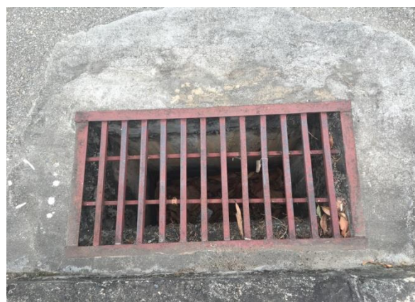
Hình 24. Rãnh và hố ga thu gom nước mưa khu vực nội bộ của Dự án
