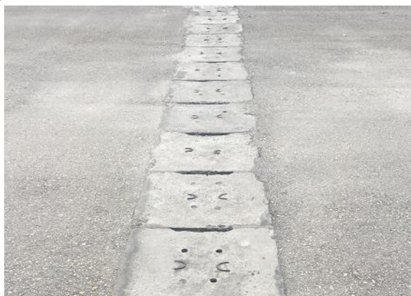
Hình 3. Hình ảnh rãnh và hố ga thoát nước mưa
