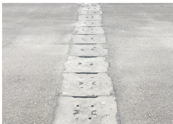
Hình 24. Rãnh và hố ga thu gom nước mưa khu vực nội bộ của Dự án
